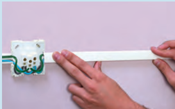
Medir, cortar e encaixar a tampa da canaleta
