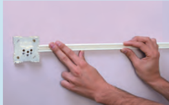
Medir para cortar a base da canaleta e fixá-la
