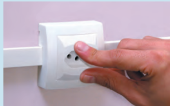
Encaixar a tampa à base do mecanismo
