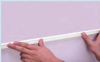
Definir o ponto, medir e cortar a base da canaleta e fixá-la na parede
