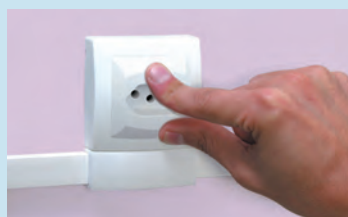
Encaixar a tampa à base do mecanismo
