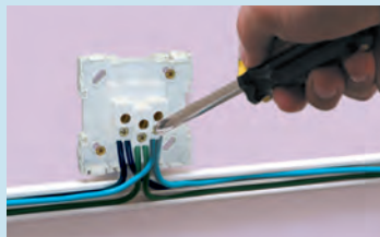
Passar os fios, cortá-los e conectá-los ao mecanismo
