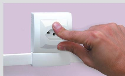
Encaixar a tampa à base do mecanismo e retirar a película protetora.
