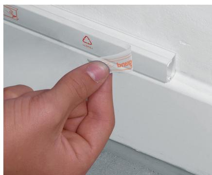
**5** Remoção da película protetora ao final da instalação.
