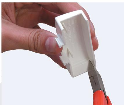
**1** Ao instalar um acoplador em uma canaleta, deve ser cortado em uma extremidade para utilizar com tampa de extremidade, ou nas duas extremidades caso a canaleta prossiga em sua instalação.
