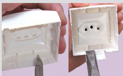
Remover o pré-corte da tampa do mecanismo para encaixar o acoplador
