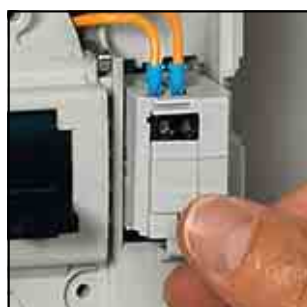
Os auxiliares elétricos são instalados em locais específicos dentro do disjuntor
