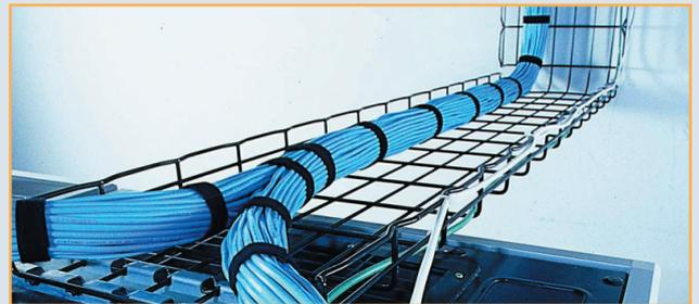
O uso de etiquetas de identificação ou o de revestimento de epóxi nas eletrocalhas ajuda a identificar as rotas de cabos e permite a atualização de redes com maior rapidez.
