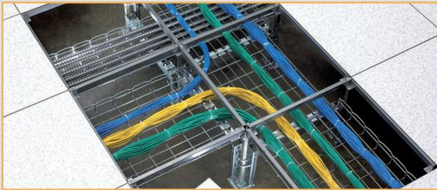
Os cabos devem ser colocados, ao invés de arrastados, na eletrocalha. A utilização de acessórios dedicados (por exemplo, FAS-ROLLER), combinada com a borda de segurança soldada em T CABLOFIL e fios arredondados, reduz o risco de torção e ruptura.
