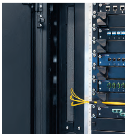
Espuma da entrada de cabos
